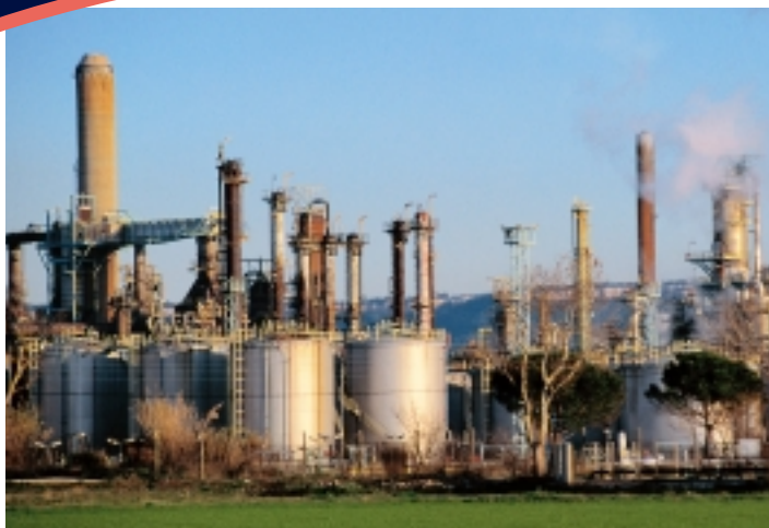
Petrochemische Anlage, Größe 30 ha
